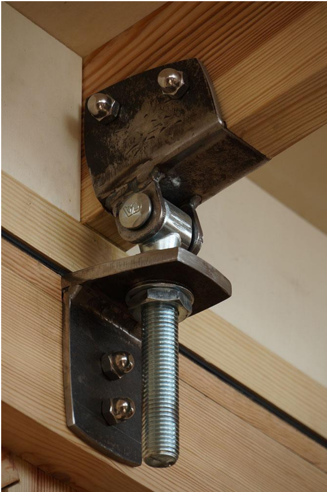
Verstelbaar scharnier om het dak mee te kunnen kantelen en (ont) koppelen
