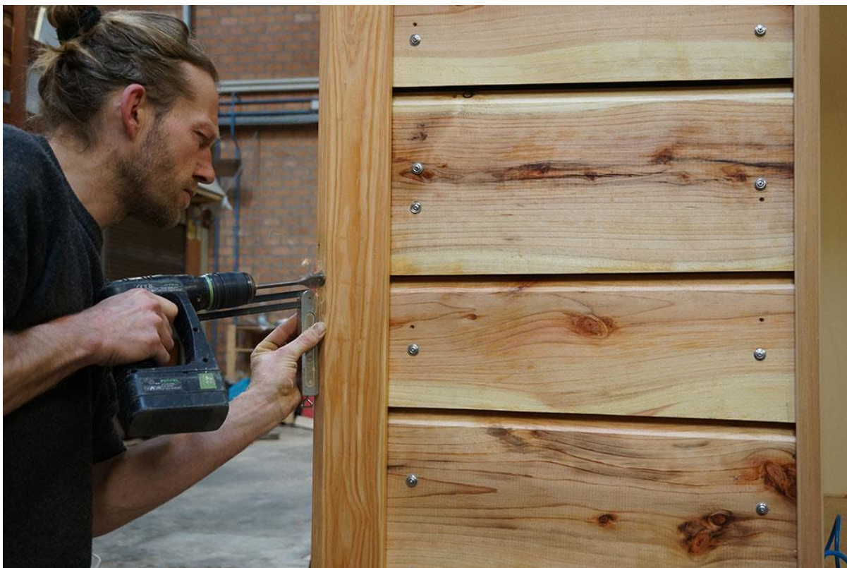
Bekleding opgesloten in een stevige hoeklijst van lariks uit het Philips de Jongh wandelpark.
