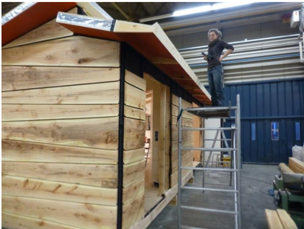
Buitenwand bekleed met watercypres. Dak overstek voor behoud van het hout. Dak overstek moet wel opgeklapt kunnen worden om over de weg te kunnen.
