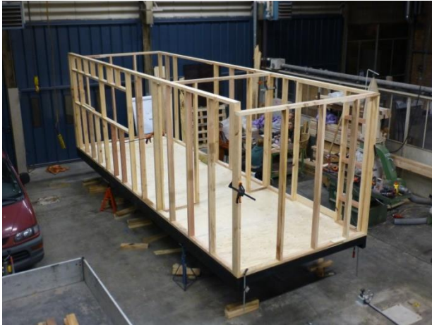
Bodem van grenen met multiplex van populier. Wanden skelet van grenen en watercypres. Spanten van grenen.
