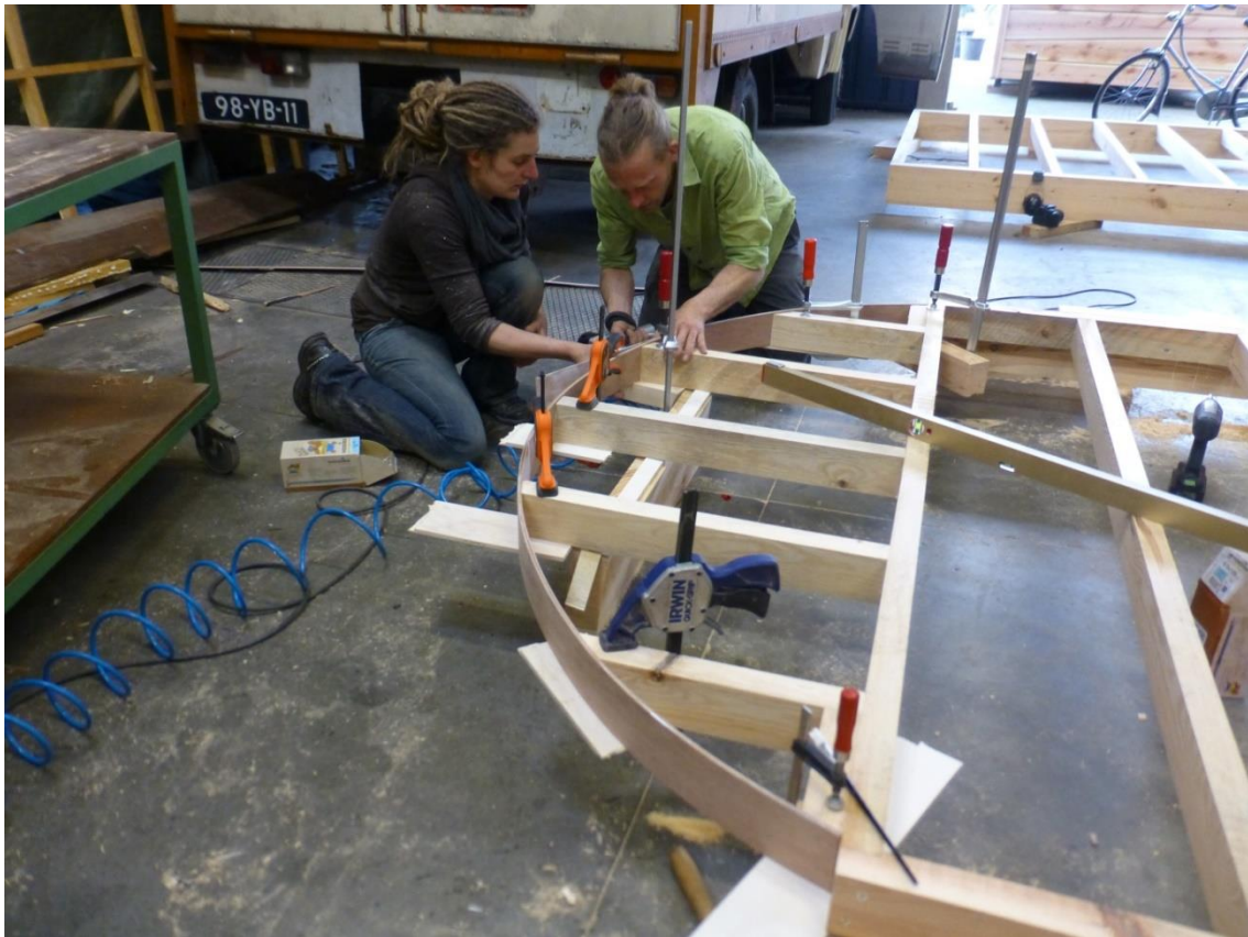
Begin van de ronding van de badkamervloer
