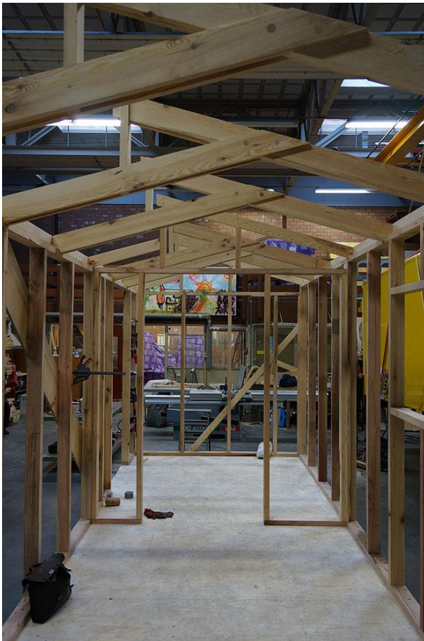
Bodem van grenen met multiplex van populier. Wanden skelet van grenen en watercypres. Spanten van grenen.
