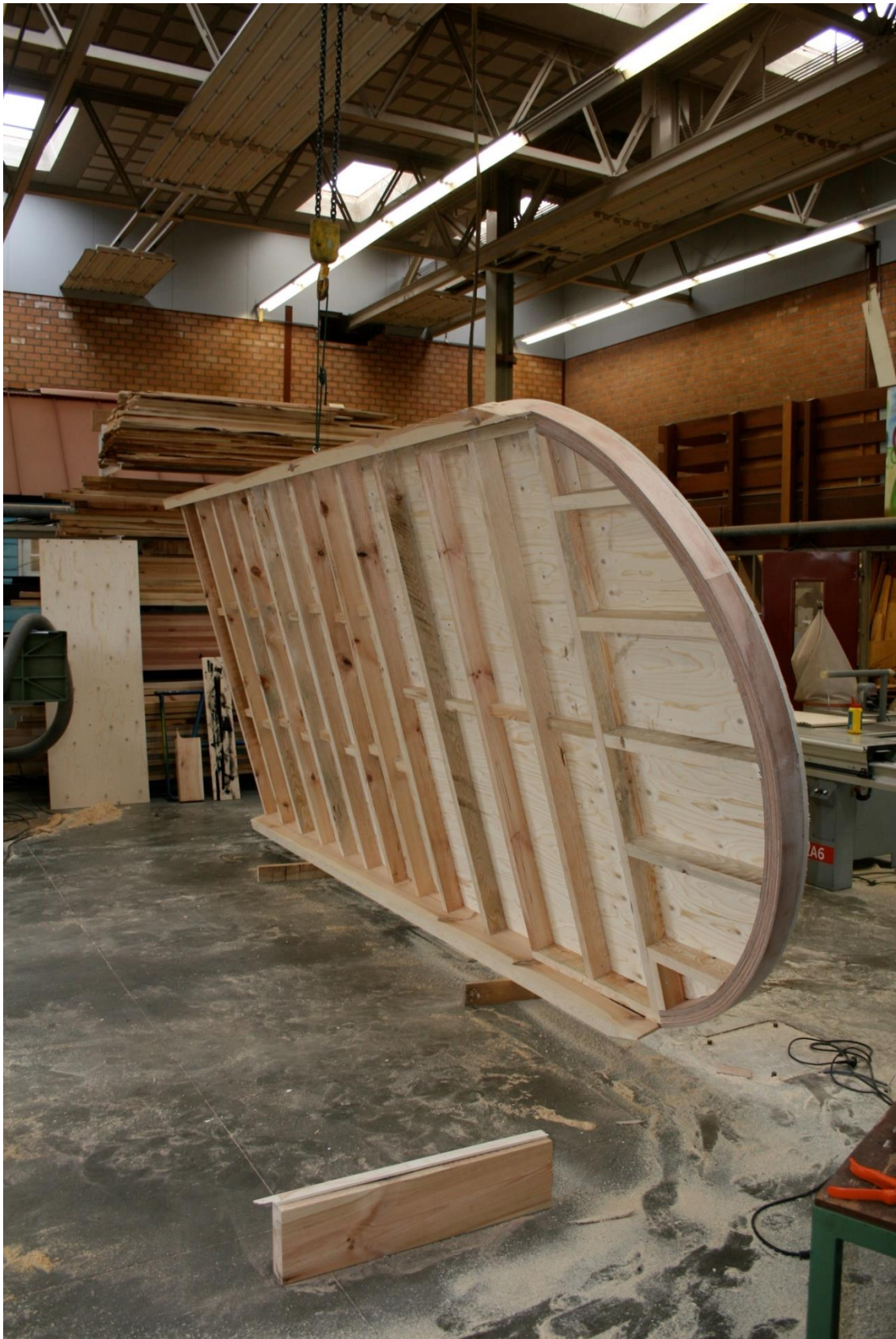
Badkamervloer in de takel
